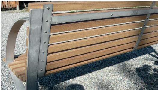
von hinten mit V<sub>A</sub>-Schrauben verschraubt
