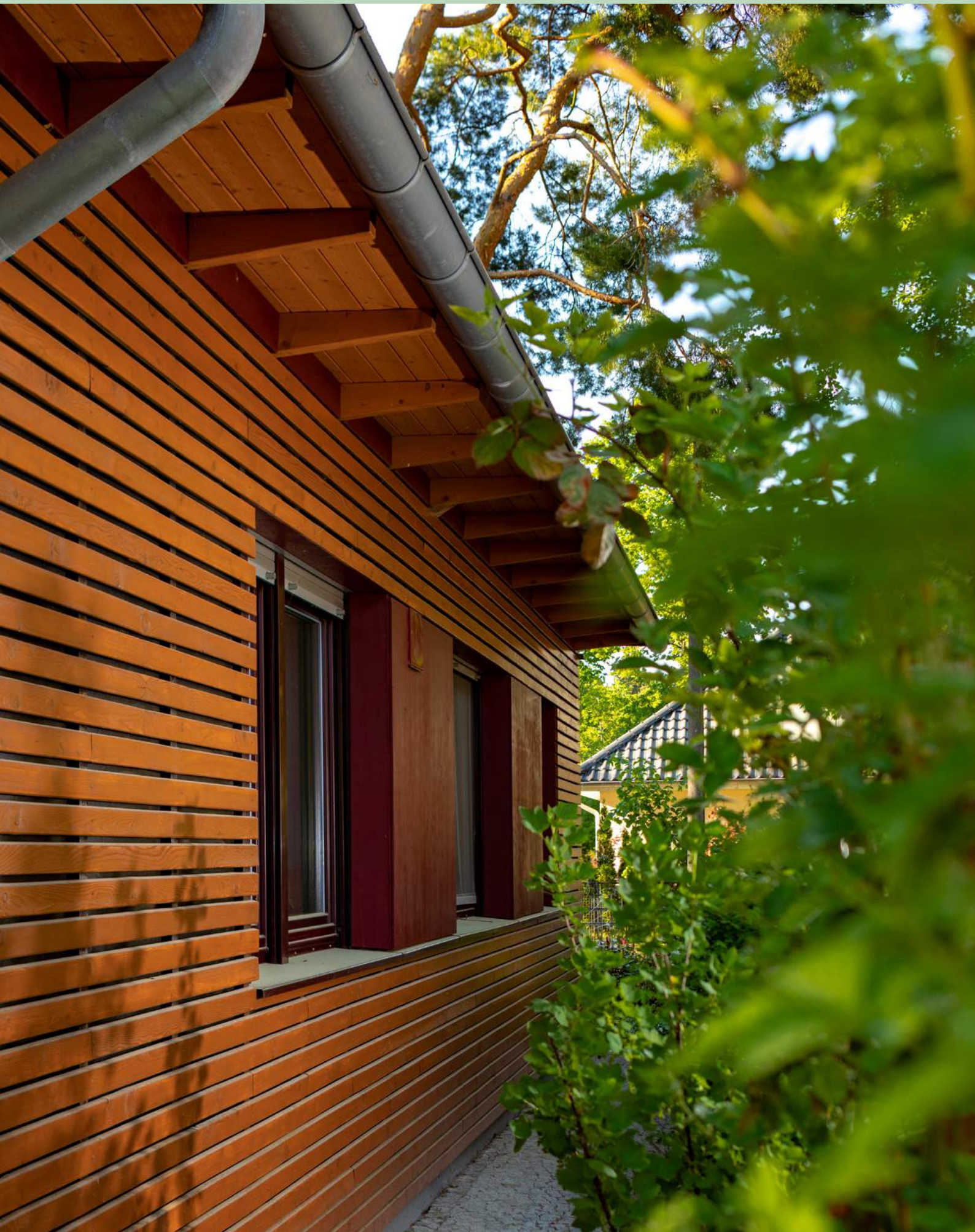
Rautenleisten sib. Lärche, endbehandelt mit Osmo Holzschutz Öl-Lasur 728 Zeder
