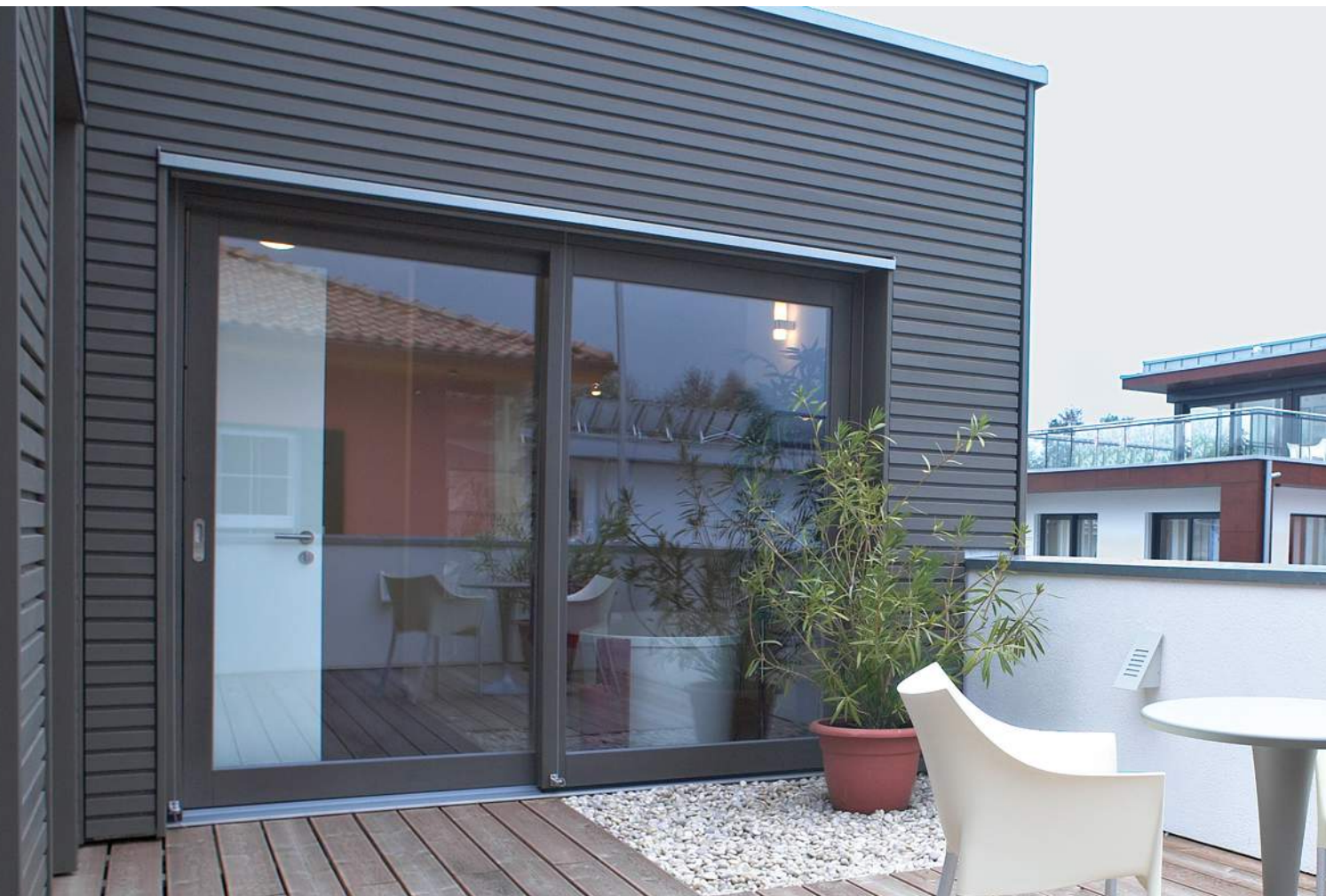
Rautenprofil, Fichte, Sichtseite gesägt, endbehandelt mit Osmo Holzschutz Öl-Lasur Effekt 1143 Onyxsilber
