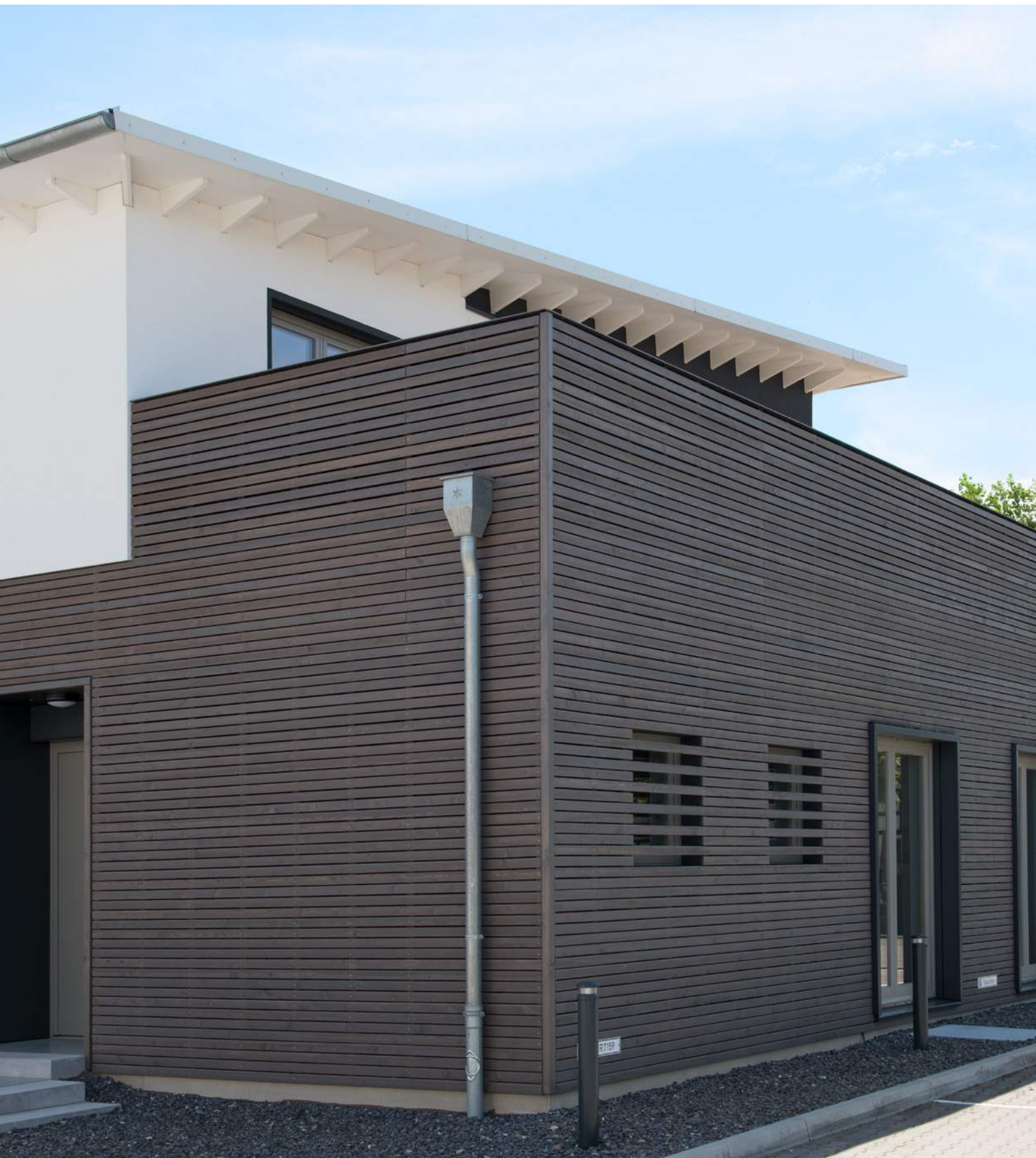
Rautenleisten Lärche, endbehandelt mit Osmo Holzschutz Öl-Lasur 905 Patina Hinweis: Durch Umwelteinflüsse kann es – insbesondere in schattigen Lagen und in der Nähe von Gewässern oder Bäumen – zu oberflächlichem Algen-/ Pilzbefall kommen. Dieser Befall ist nicht auf Materialfehler, sondern auf Sporenflug zurückzuführen.
