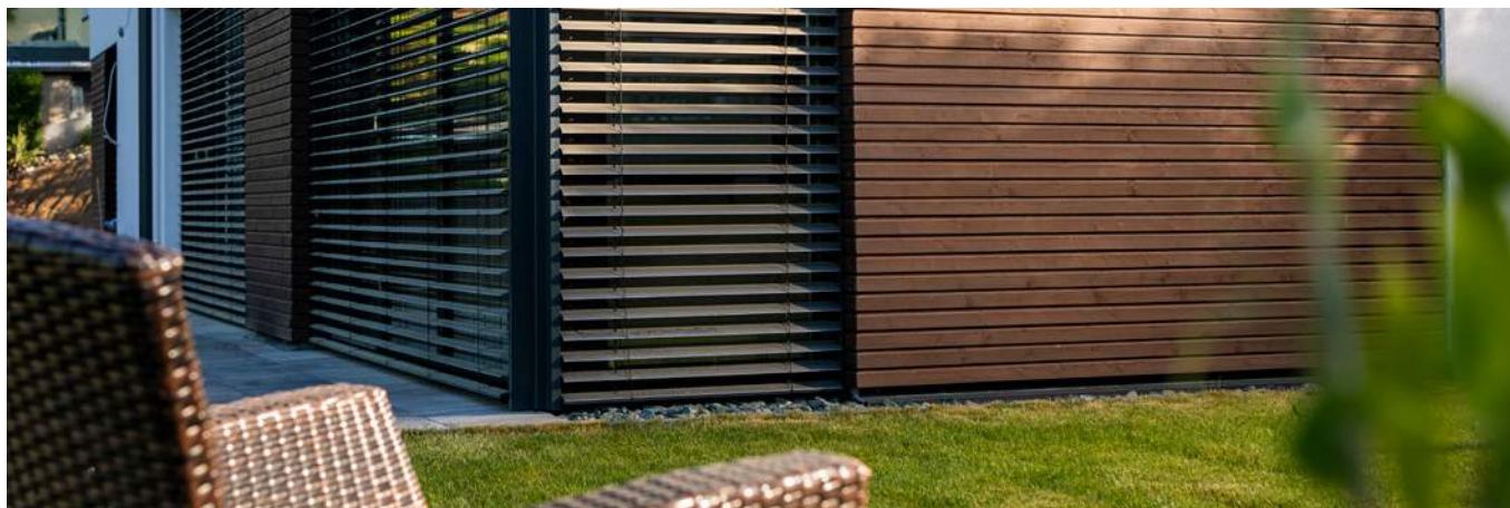
Rautenprofil mit Nut und Feder, nordische Fichte, endbehandelt mit Osmo Holzschutz Öl-Lasur 727 Palisander
