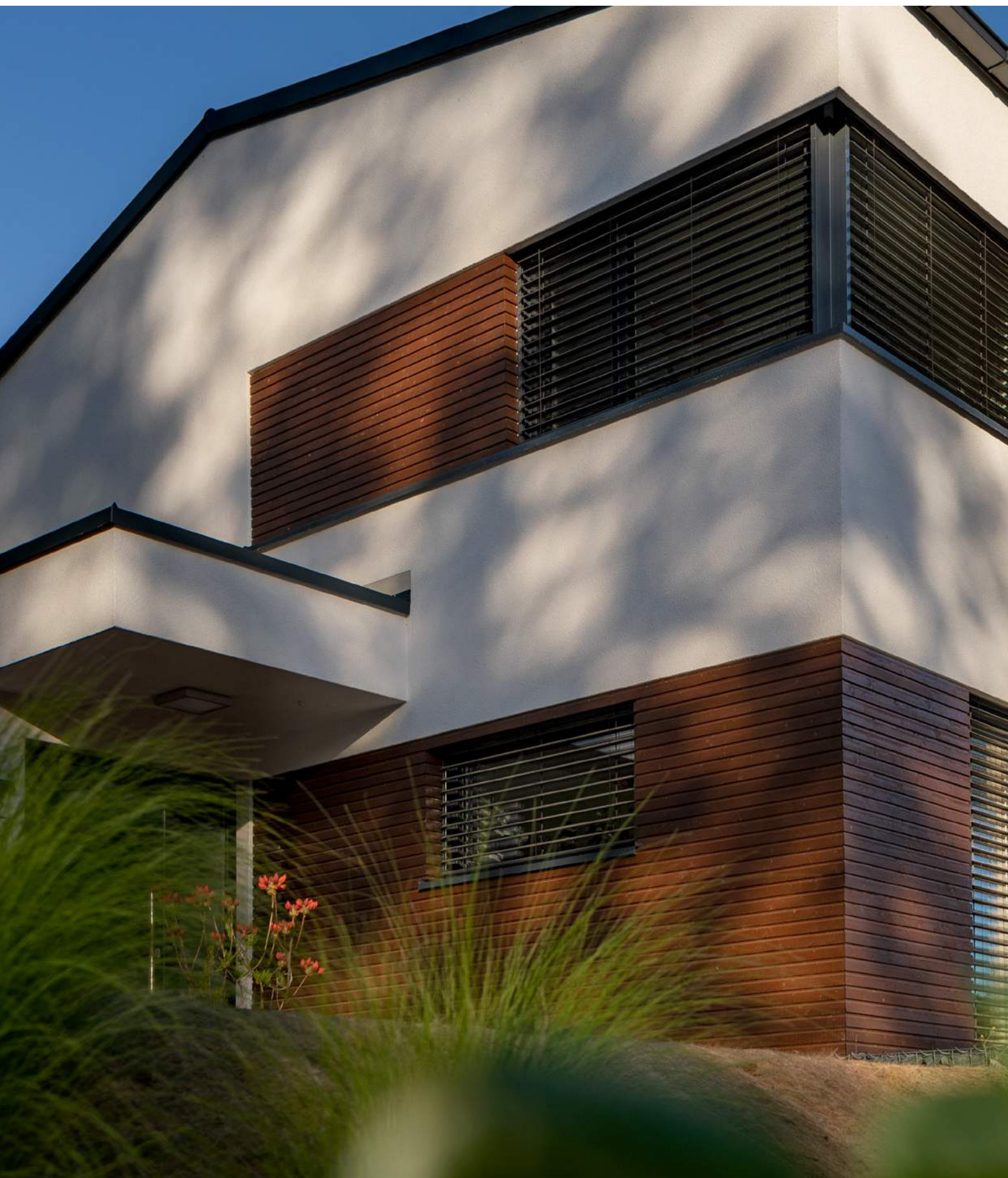
Rautenprofil Fichte, endbehandelt mit Osmo Holzschutz Öl-Lasur 707 Nussbaum
