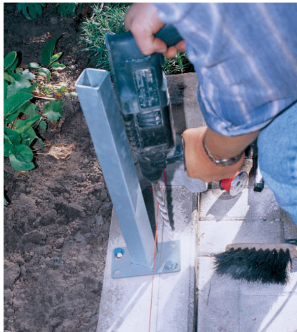
oder mit Pfostenträger aufschrauben.
