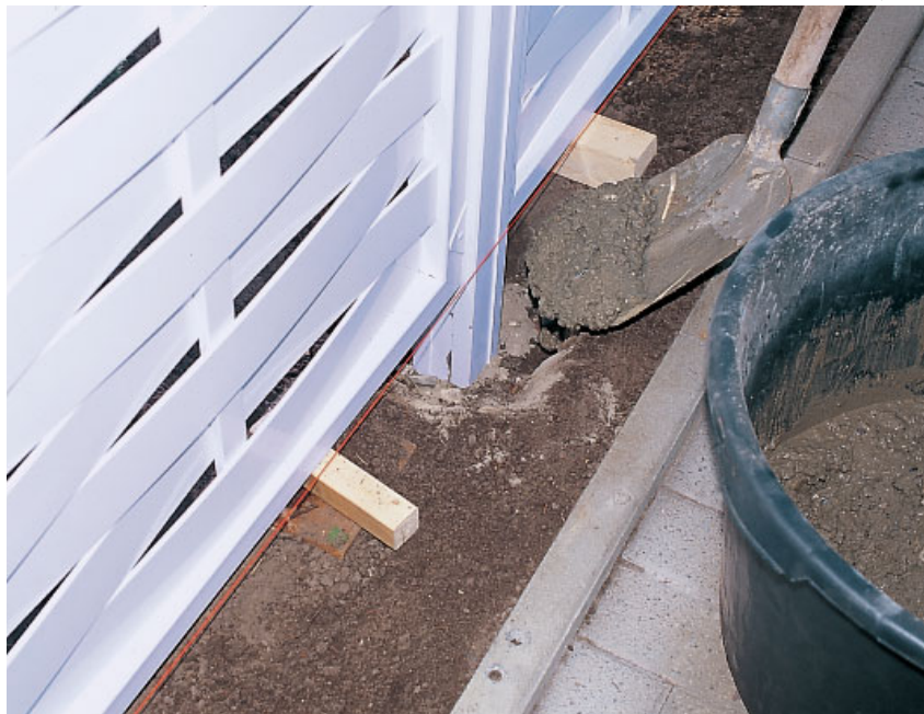
Pfosten direkt ins Erdreich einbetonieren...
