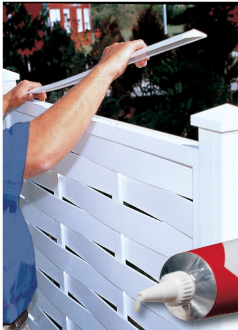
Kleber (0783) zur Befestigung der Aufsatzleisten und Kappen.
