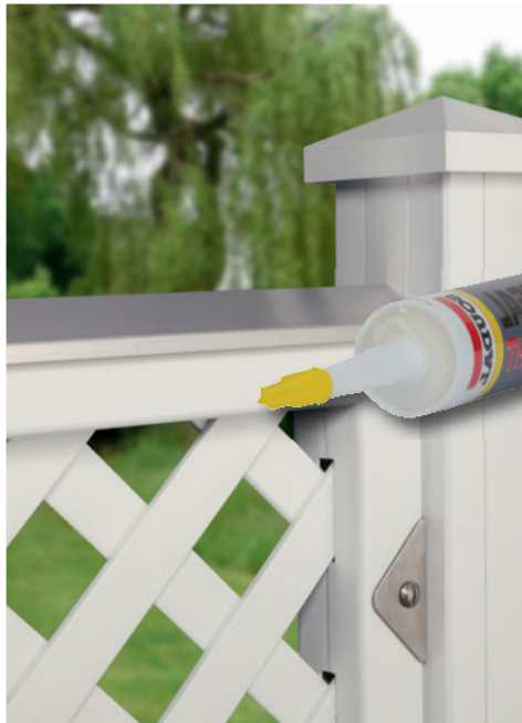
Designaufsatz Alu mit MS-Polymer-Kleber (1398) befestigen.
