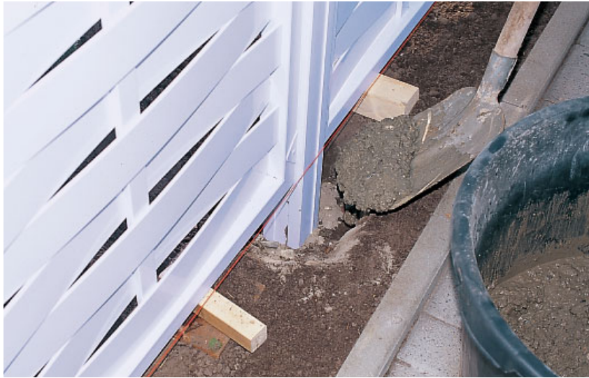
Pfosten direkt ins Erdreich einbetonieren...
