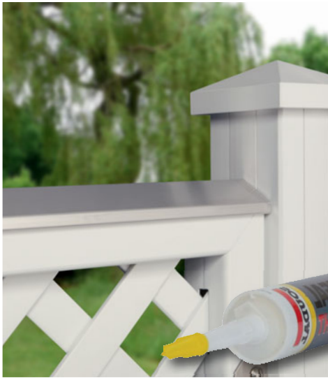
Designaufsatz Alu mit MS-Polymer-Kleber (1398) befestigen.
