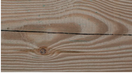
Spannungsrisse durch die Holz Trocknung
