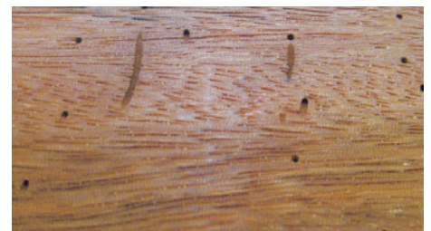
„Pinholes“ bei überseeischen Harthölzern
