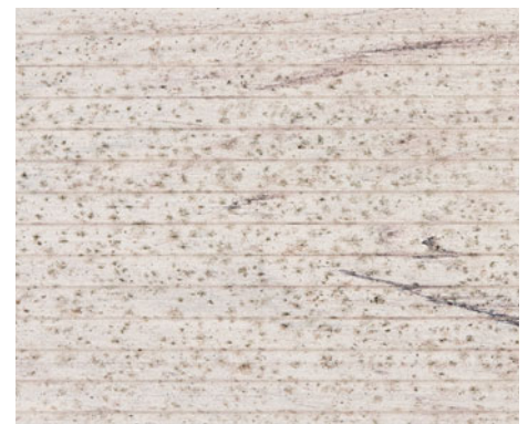
Stockflecken/Schimmel auf der Oberfläche
