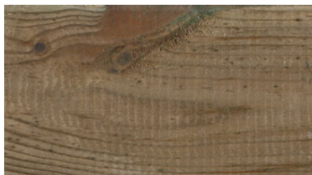
Raue Stellen auf der Holzoberfläche
