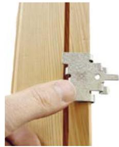
Montageclip positionieren und mit leichtem Druck einfügen
